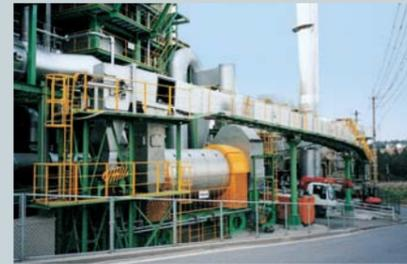
汚泥搬送ラインとして活躍するスーパーコンベヤ。傾斜搬送とカーブ搬送を組み合わせで設置されています。フラットベルトの場合はベルトに付いた搬送物がダストパンに溜まってしまいます。スーパーコンベヤの場合はリタン側も円筒形になるため、ダストパンへの溜まりは極めて少なくなることが特徴です。
