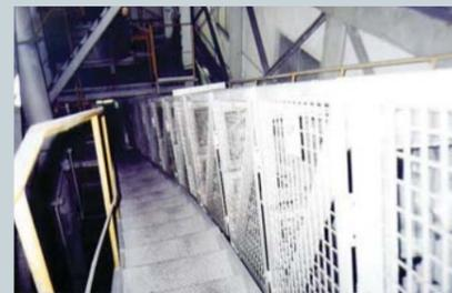
ゴミ焼却場で、焼却灰の搬送に活躍するスーパーコンベヤ。比重が軽いため飛散しやすい焼却灰も、円筒形に成形されたベルトが素早く包み込んで搬送します。搬送中に灰が外気に触れることもありません。このような特長から、リターン側のダストパンなどへの溜りも軽減できるほか、清掃の手間が大幅に省け、工場内の環境対策にも貢献しています。
